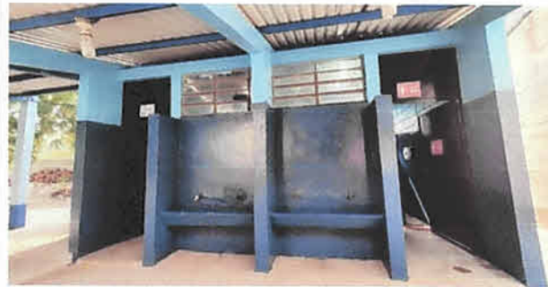
Foto 2: pintura de baños y puertas
