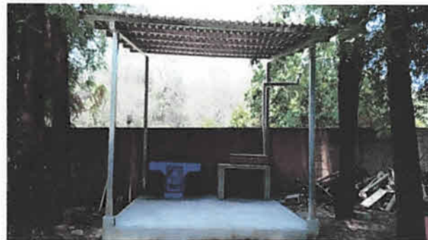
Foto 4: Remodelacion de cocina
