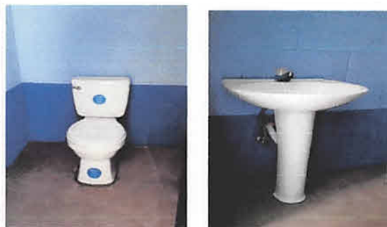
Foto 5: Ampliación de baños
