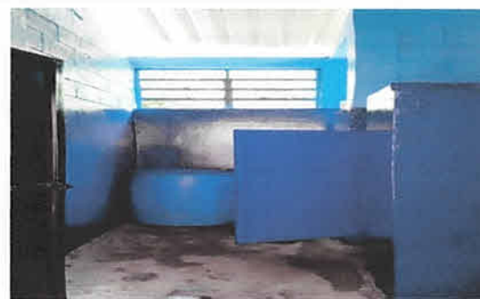
Foto 6: Mantenimiento de puertas y pintura
