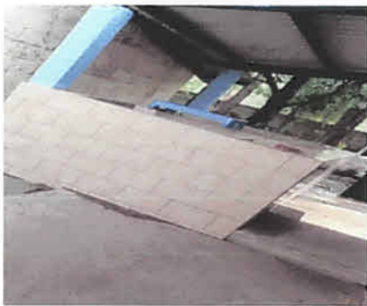
Foto 3: Colocación de azulejos en pila
